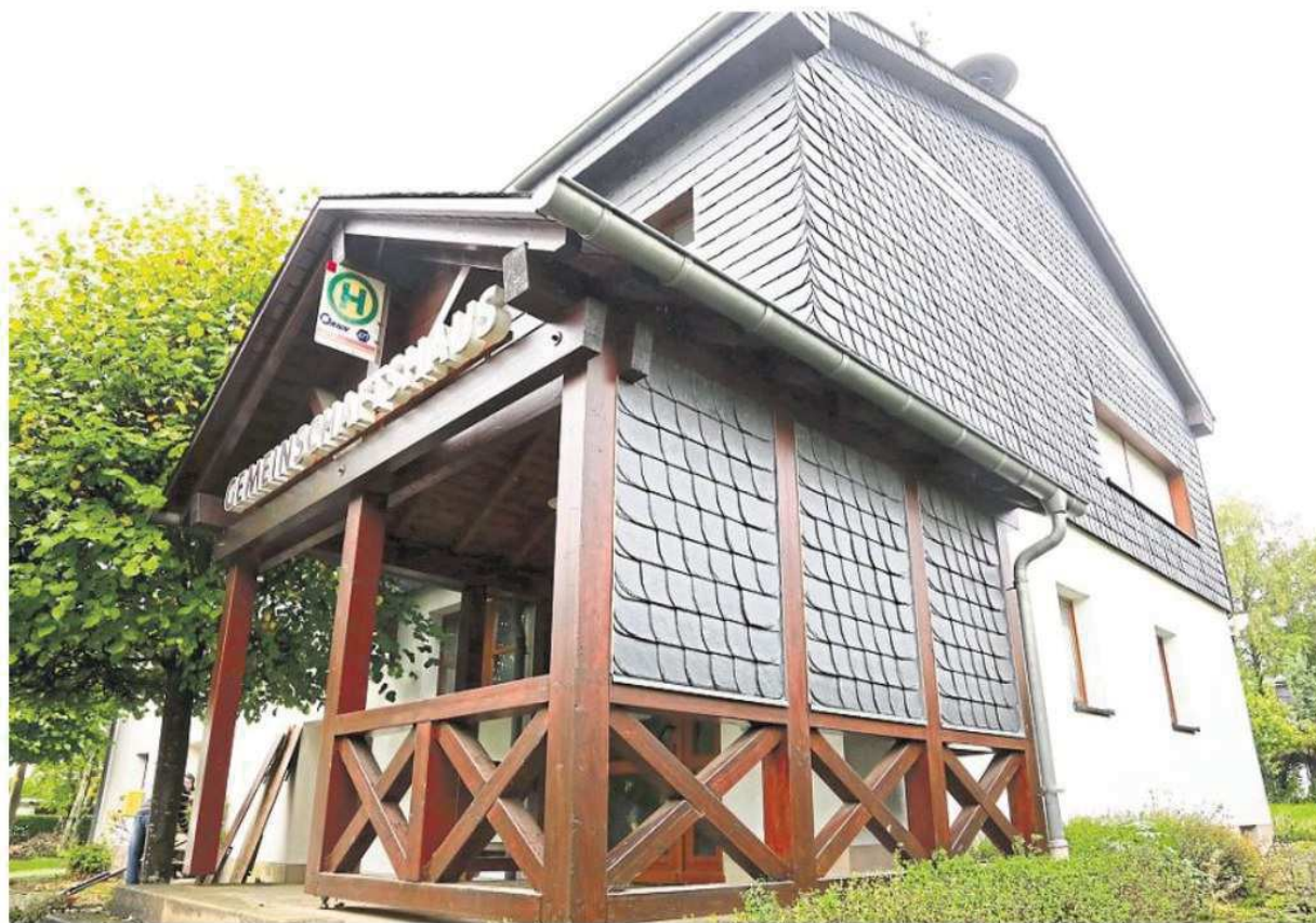
Das Oberhambacher Gemeinschaftshaus macht optisch immer noch einen schicken Eindruck. Im Untergeschoss befinden sich aber seit Jahren leer stehende Räume, in denen nach umfangreichen Umbauarbeiten bis Herbst 2021 ein Gesundheitstreff entstehen soll.
