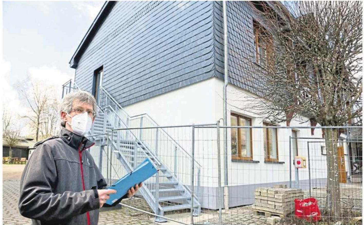
Ortschef Günter Stolz begutachtet die vor wenigen Tagen installierte Treppe am Oberhambacher Gemeinschaftshaus, die als zweiter Rettungsweg vom Saal ins Freie führt. Im Erdgeschoss entsteht der Gesundheitstreff. Dafür wurden an der Frontseite neue, größere Fenster eingebaut. Foto: Reiner Drumm
