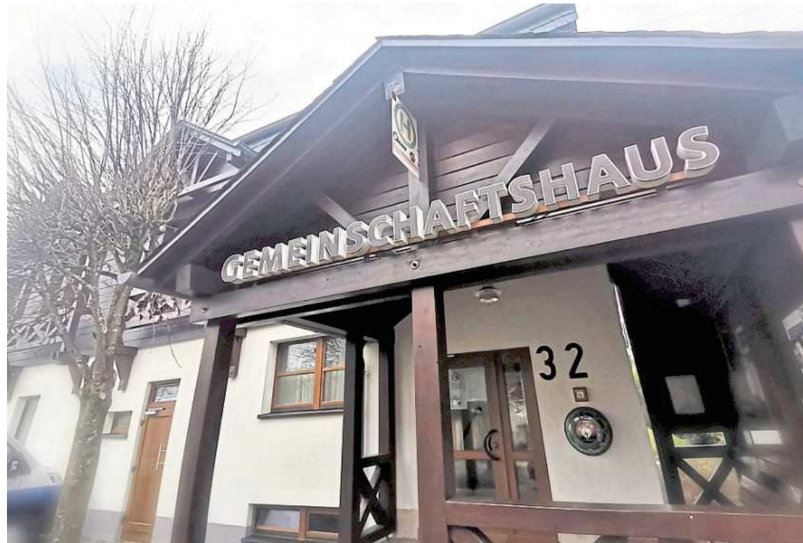
Im Inneren des 1969 erbauten Gemeinschaftshauses von Oberhambach laufen seit etwas mehr als einem Jahr umfangreiche Umbauarbeiten. Denn aus den Räumen des früheren Schlachthaus wird ein Gesundheitstreff. Wann dieser eröffnet werden kann, ist aber noch unklar. Foto: Reiner Drumm
